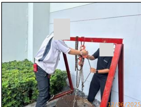
รูปที่ 2-31 การตรวจสอบและตัดไขมันในบ่อดักไขมัน
