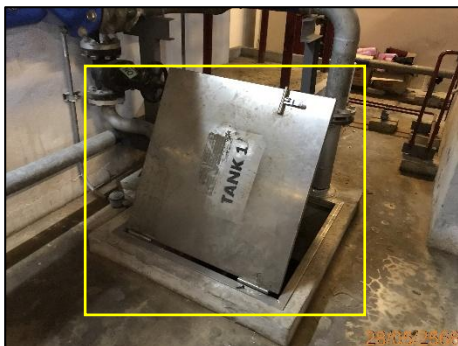
รูปที่ 2-27 ถังเก็บน้ำสำรองชั้นใต้ดิน
