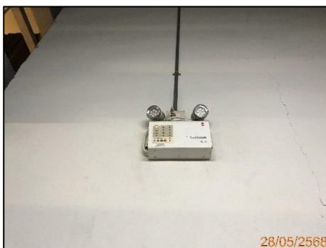
รูปที่ 2-55 ไฟส่องสว่างฉุกเฉิน
