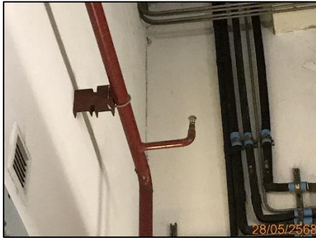
รูปที่ 2-51 ระบบดับเพลิงอัตโนมัติ
