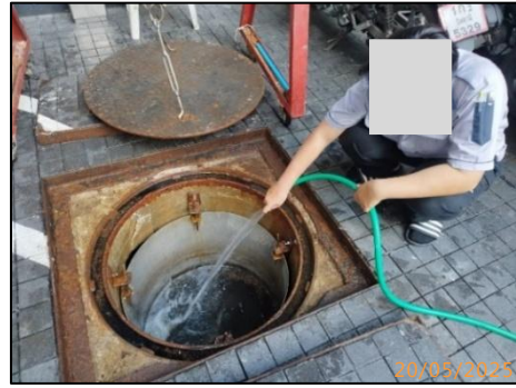
รูปที่ 2-33 การตรวจสอบและการทำความสะอาดบ่อพักน้ำ
