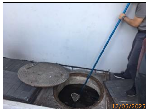
รูปที่ 2-31 การตรวจสอบและตัดไขมันในบ่อดักไขมัน
