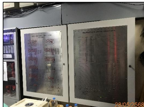
รูปที่ 2-42 แผงควบคุมระบบแจ้งเหตุอัคคีภัย
