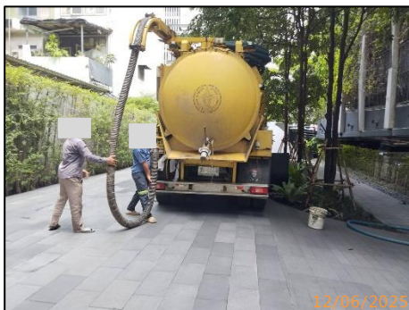
รูปที่ 2-26 การสูบน้ำส่วนเกินจากระบบบำบัดน้ำเสีย
