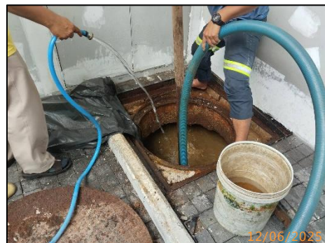
รูปที่ 2-26 การสูบน้ำส่วนเกินจากระบบบำบัดน้ำเสีย
