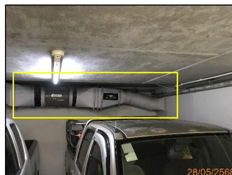
รูปที่ 2-23 พัฒนาระบายอากาศที่อาคารจอดรถ
