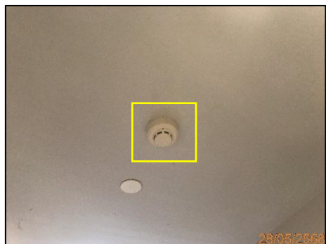
รูปที่ 2-44 เครื่องตรวจจับความร้อน
